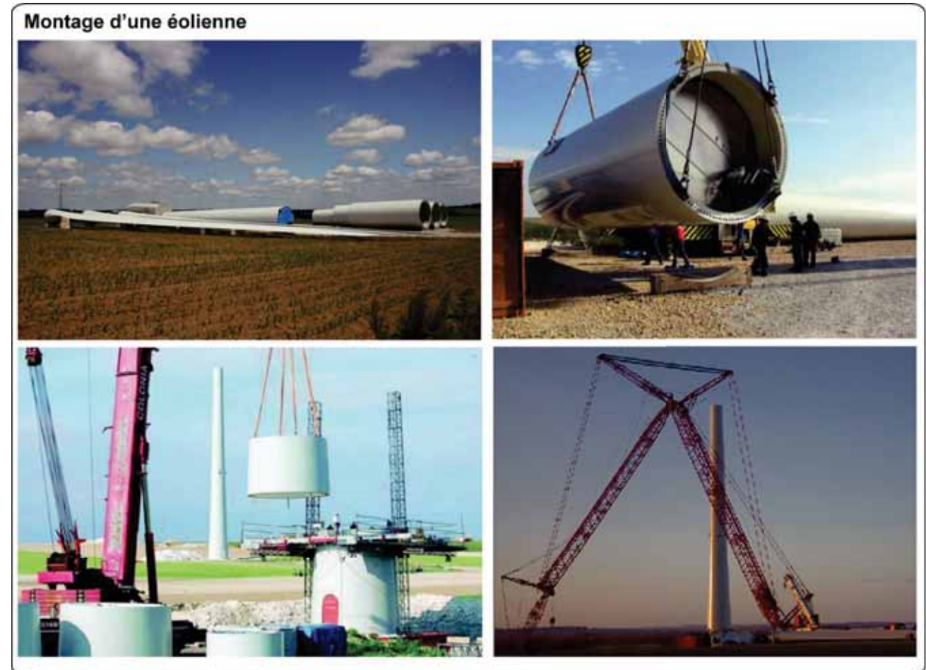
Photographie 27 : Phases d'assemblage d'une éolienne
