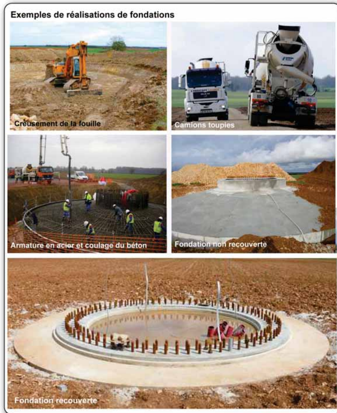
Photographie 25 : Etapes de réalisation d'une fondation d'éolienne
