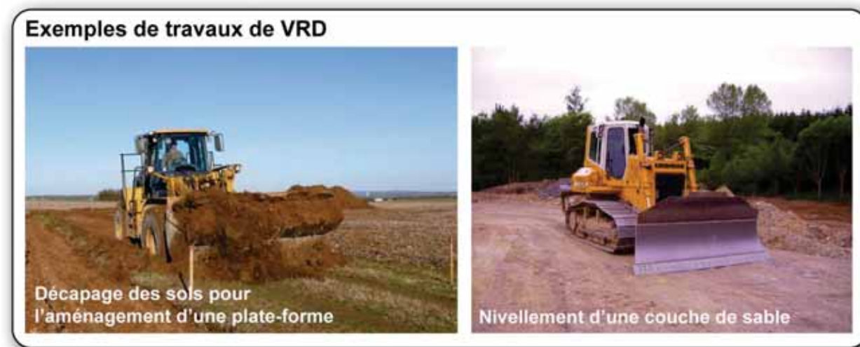
Photographie 24 : Exemples d'engins de travaux de VRD
