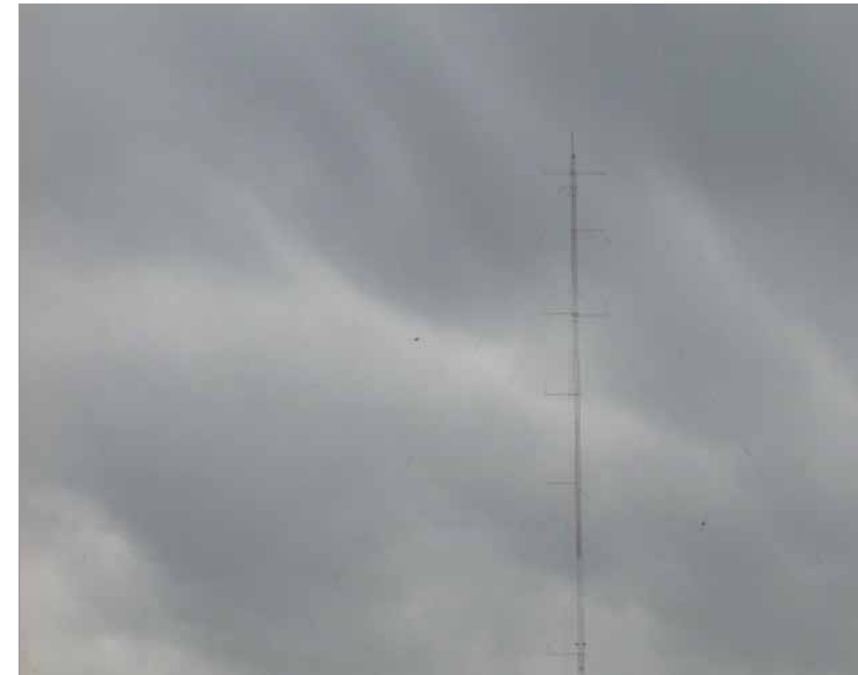
Photographie 1 : Mât de mesures installé sur site (source : ENCIS Environnement)
