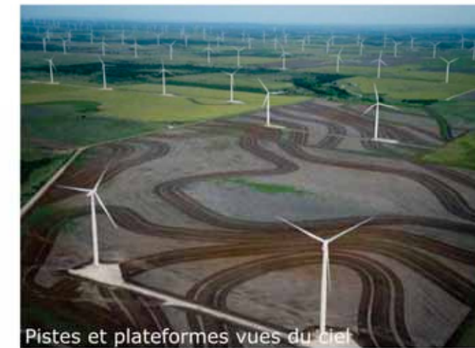
Photographie 20 : Exemples de plateformes de montage et de pistes
