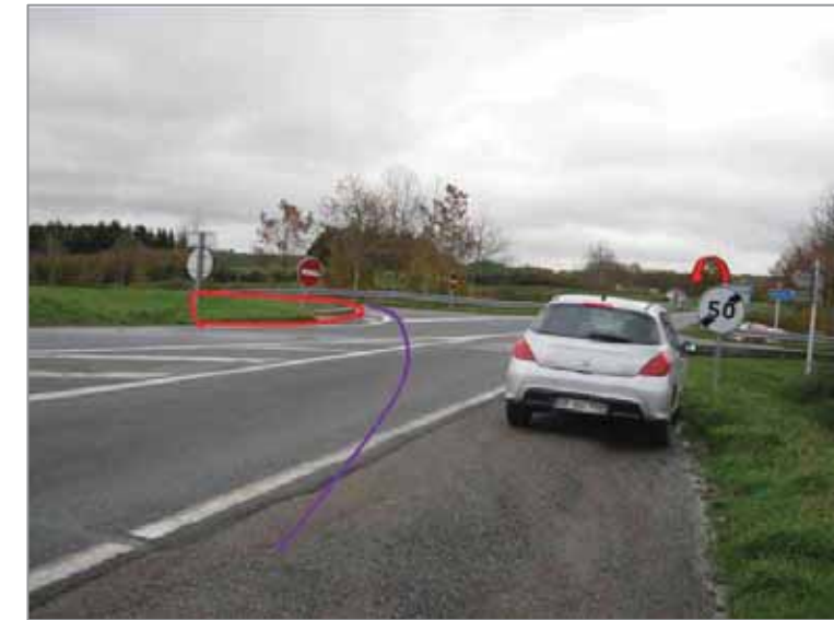
Photographie 22 : Aménagement de la bretelle de sortie 21 de l'A20 (source : Transports Capelle)
