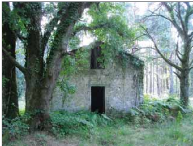
Photographie 11 : Maison en ruine présente dans la zone sud
